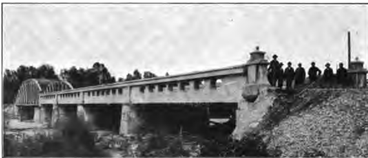
Abb. 85. Zufahrtfelder der Ybbs-Brücke bei Kammelbach (Niederösterreich).
